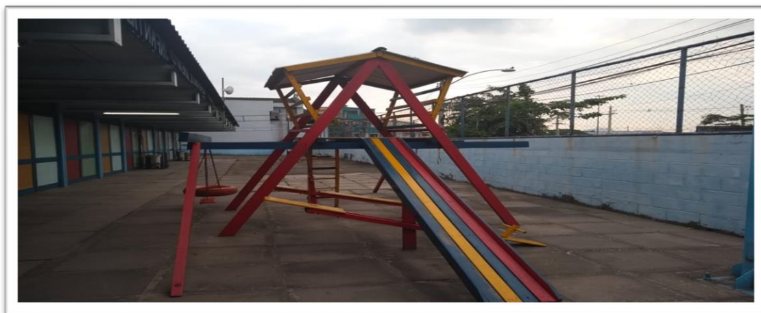
Figura 5: Fotos da área externa frontal da escola (Fonte: acervo nosso)
