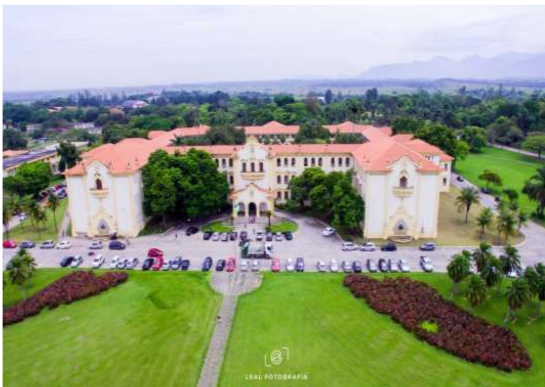
Figura 2. Fotografia aérea do prédio Pavilhão Central da Universidade P1.
